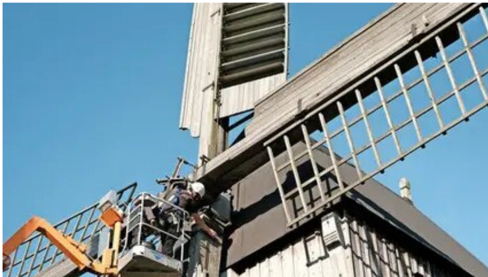
Schrauben lösen: Die Mitarbeiter der Zimmerei „Der Holzmichel“ arbeiten an dem ersten Flügel der Mühle.
