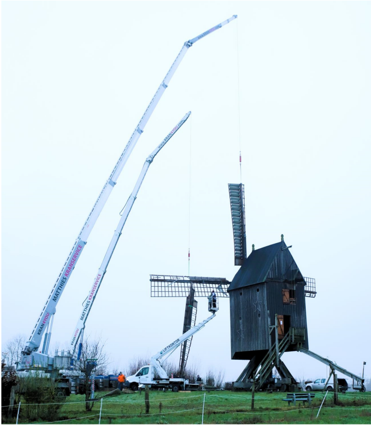
Beginn der Demontage
