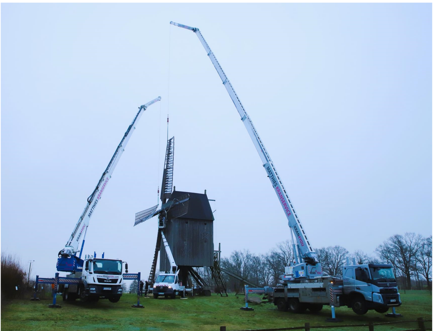
Beginn der Flügel und Bruststück Demontage.
